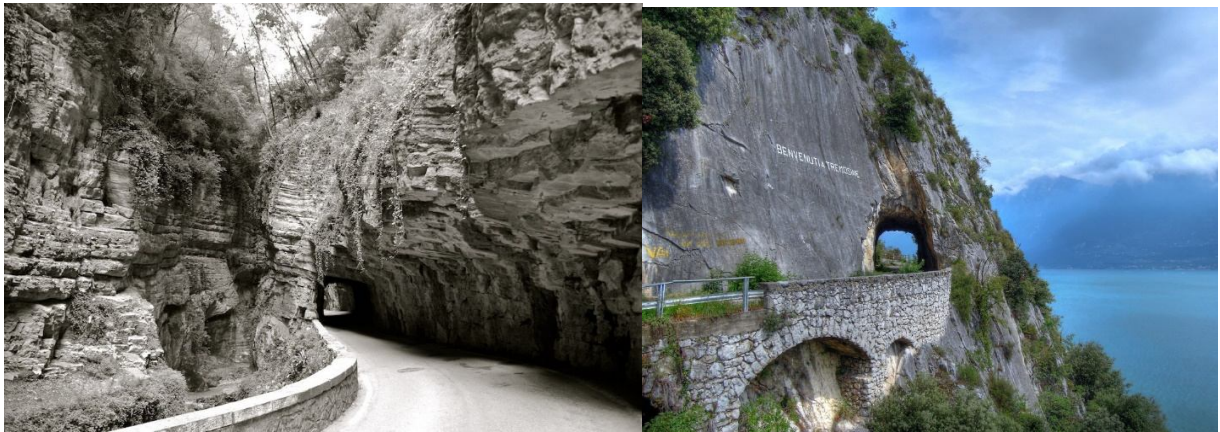
Strada della Forra
